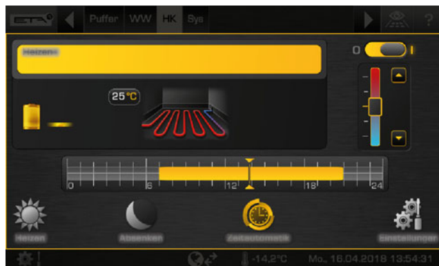
Sl. 7-90: Talno gretje brez sobnega termostata
