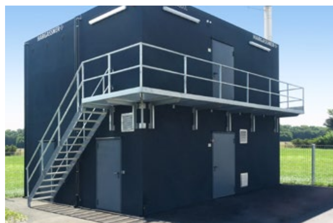
Štirikontejnerska kotlovnica na sekance pri industrijskem objektu.
