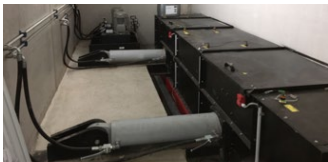
Masivni hidravlični pogoni za premikanje pomičnih tal
